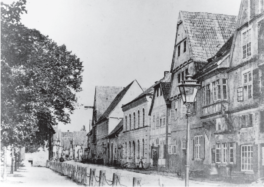
Andreas Koch wohnte im Pfarrhaus an der Papenstraße 14 – noch heute eine der Kirchengemeinde St. Nicolai gehörige Dienstwohnung. Das alte Haus (auf der Abbildung hinter der Laterne) wurde allerdings 1889 abgebrochen und durch einen Neubau ersetzt.
